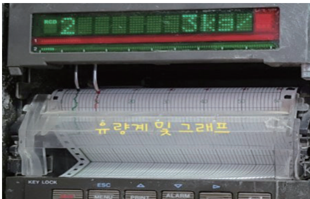
(T.S.M 주입압력과 주입량 측정)
