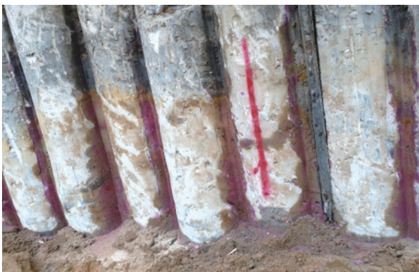
(T.S.M 시공 후 착색 후 시험)
